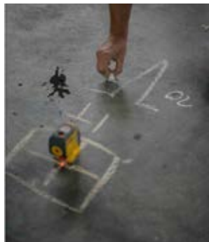
4 Headrigger bei der Arbeitsvorbereitung und Detailplanung
